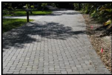
Pervious Pavement (Siesta Key, Florida)
